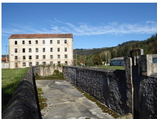
Figuras 4 a 7: Obras hidráulicas de la antigua fábrica de harinas La Inesuca: azud sobre el río Besaya y dique de sillares pétreos en la entrada del canal de derivación. Fábrica de harinas La Herrán: edificio y cámara de carga, y azud asociado (LVC).
