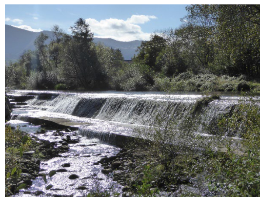
Figuras 4 a 7: Obras hidráulicas de la antigua fábrica de harinas La Inesuca: azud sobre el río Besaya y dique de sillares pétreos en la entrada del canal de derivación. Fábrica de harinas La Herrán: edificio y cámara de carga, y azud asociado (LVC).
